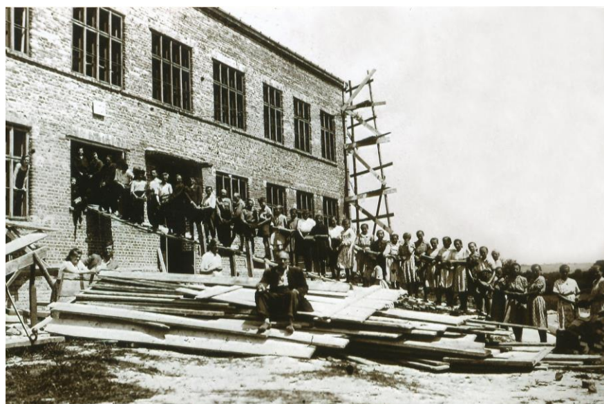
Zdjęcie wykonane wiosną 1954 r. w trakcie pracy, budowy szkoły w Gorajcu – podawanie cegły przez uczniów
