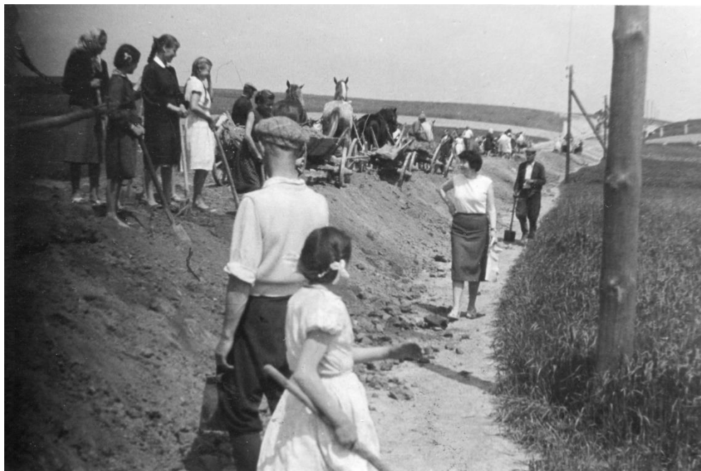
Budowa drogi od kościoła w kierunku cmentarza. Wśród pracujących młodzież szkolna oraz Aniela Bielecka – kierownik szkoły
