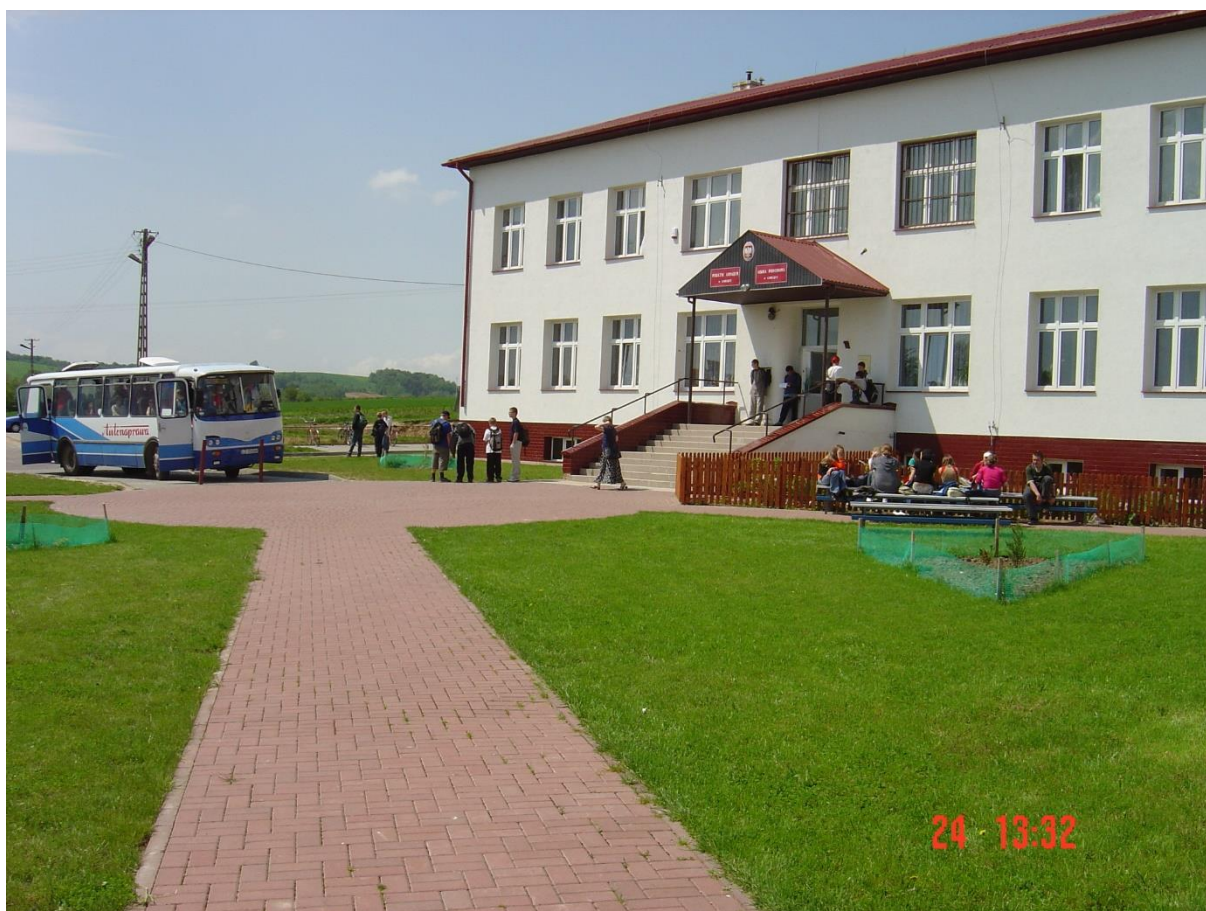
Zasadzone krzewy na poszczególnych częściach trawnika
